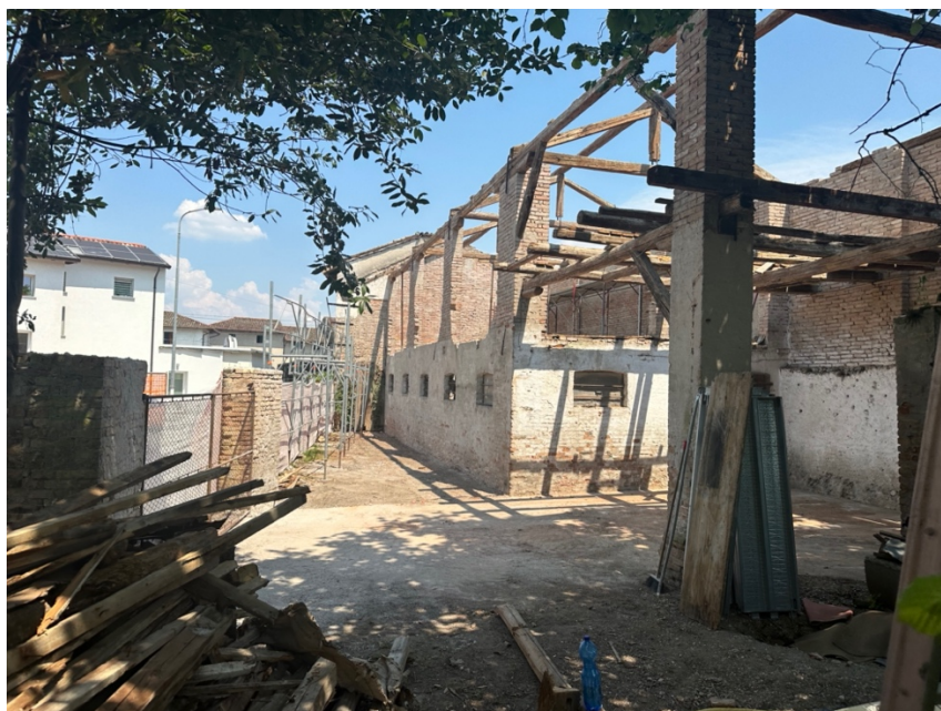
Foto n.2: Situazione edificio accessorio (ex stalla-fienile) lato interno.
